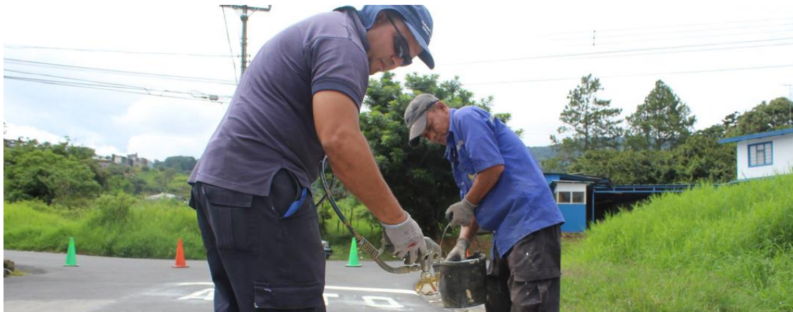
Fig 3. Labores de demarcación
