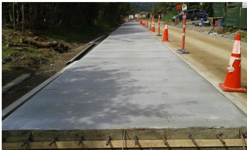
Fig 4. Etapa de Construcción losa de concreto
